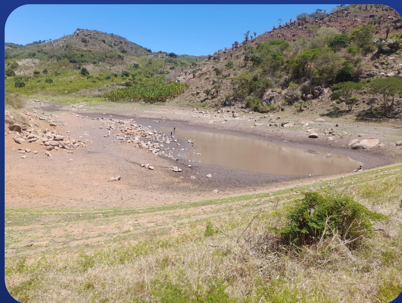
Águas Belas - Barragem de Nível
